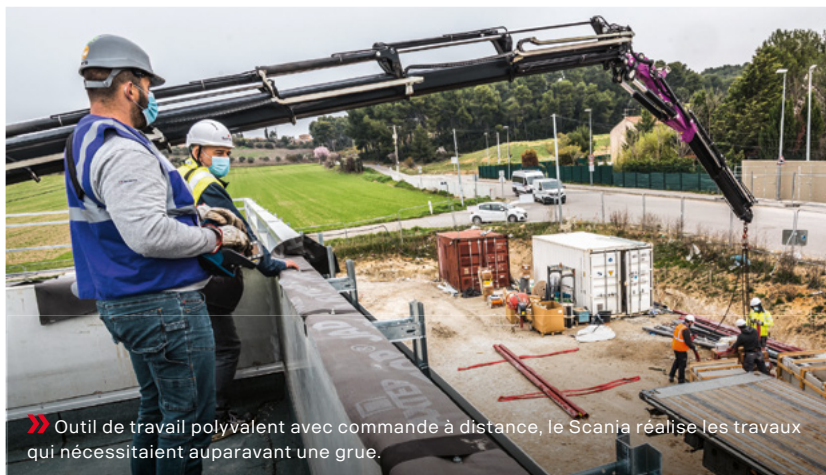
» Sur les chantiers de construction, le Scania en version porteur avec sa grue Fassi de 135 t.m permet de monter le matériel directement sur le toit.
